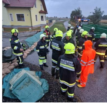
August 2024 – T1 Dammbau
