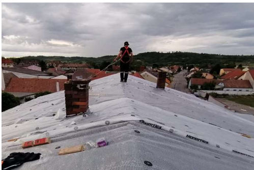
Juni 2021 – Unwettereinsatz Ziersdorf
